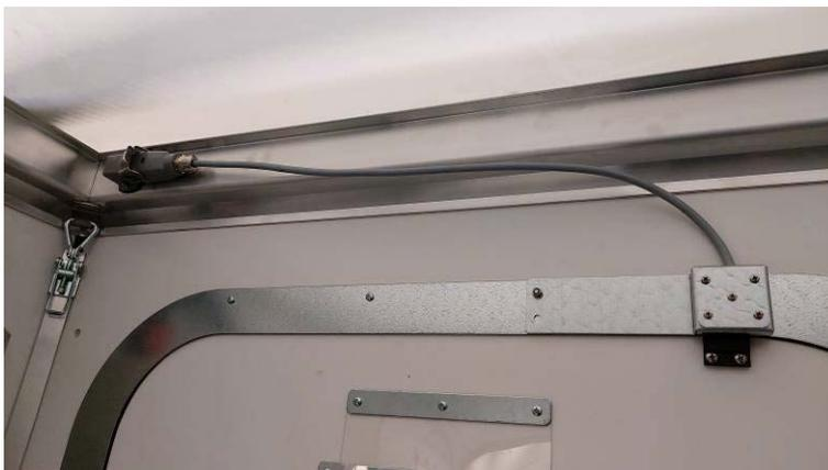
1. Kabel am Stecker des Dachelements über der Tür Weißbereich an den Eingang „1“ am Lufterzeuger anschließen.
