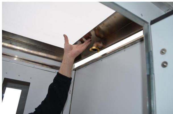
Raccorder le dispositif de douche au raccord Geka de l'élément de toit.
