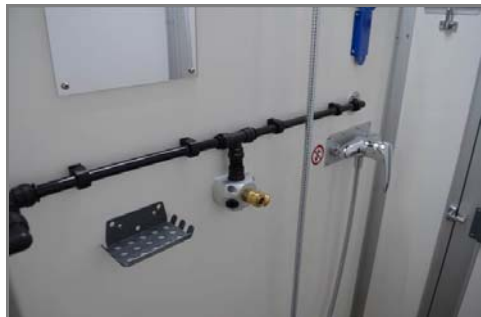
Abb. 125 Druckluftanschluss
