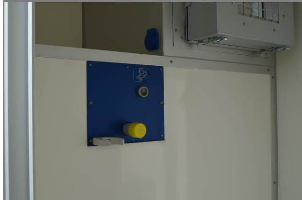
Abb. 128 Saugeranschluss
