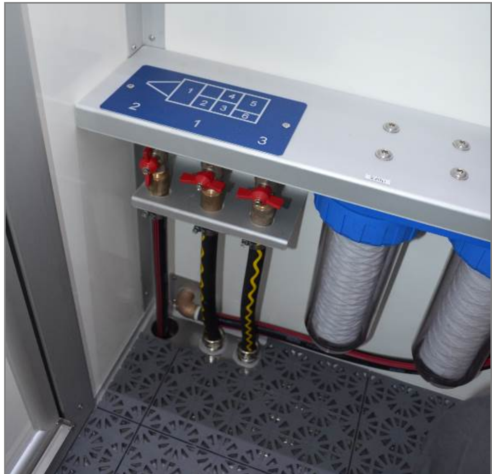
Abb. 13 Kugelhähne in der Duschkammer
