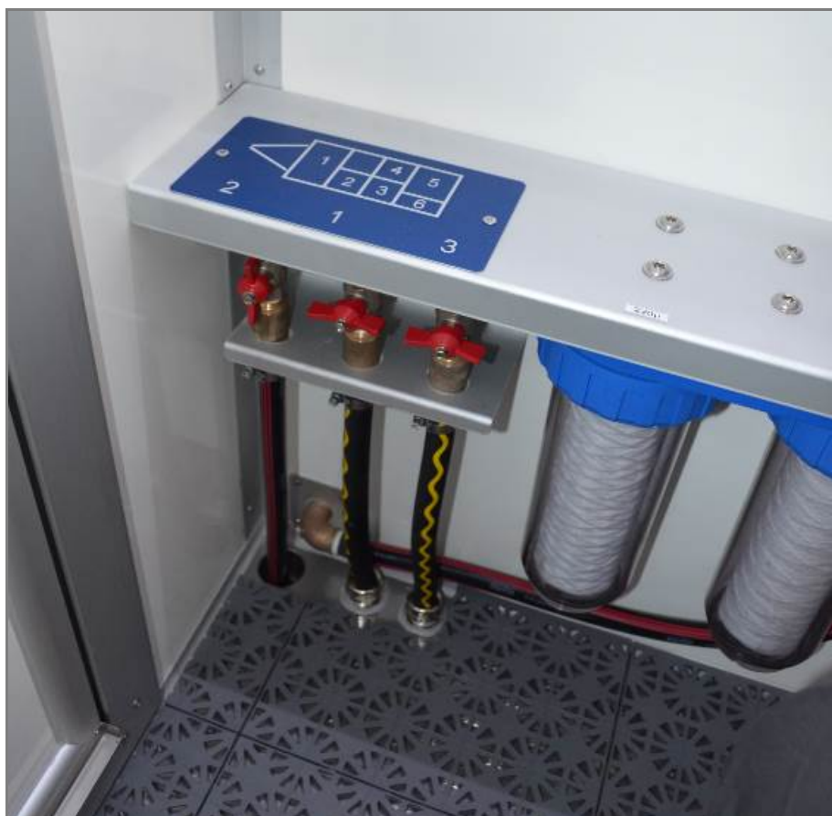
Illustration 13 Robinets à boisseau sphérique dans le compartiment de douche
