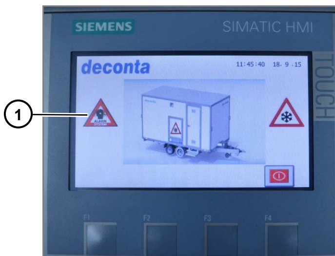
Abb. 67 Stato dell'impianto di allarme
