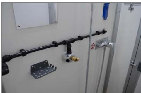
Abb. 125 Collegamento dell'aria compressa
