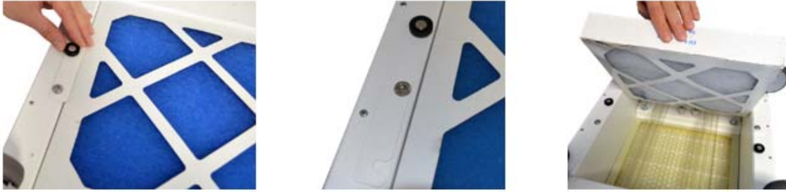
Abb. 30 Rändelmutter und Filterentnahme
