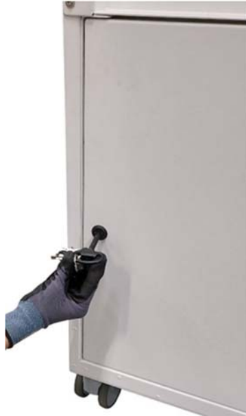
Abb. 26 Tür zum Filterraum mit dem mitgelieferten Schlüssel öffnen
